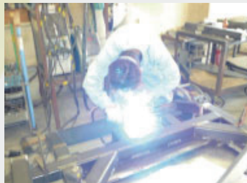
溶接作業風景
